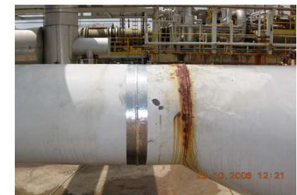
용접부분 Zinc Tape 시공
